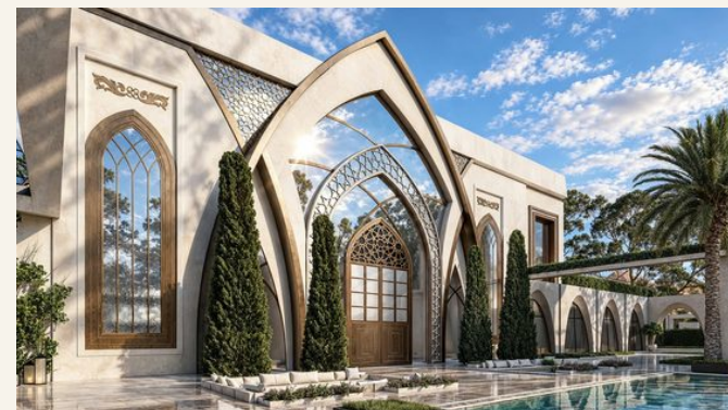
Entrée et détail des matières
